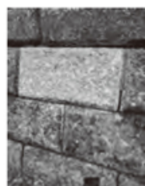
テスト 施工後
