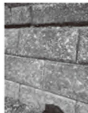
テスト 施工前
